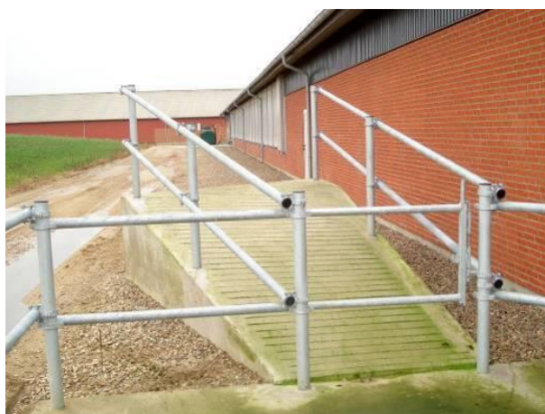
Der er en låge imellem boksen og rampen, så dyrene får ikke adgang til rampen, før de skal op i bilen. Rampen er profileret for at give bedst mulig skridsikkerhed.
