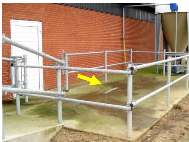
I udleveringsboksen er det betonbund med fald til afløb (gul pil).
